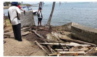
Daños por la acción del mar a los muros de protección a las instalaciones
