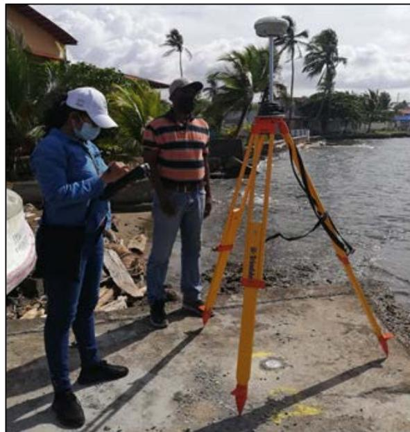
**Foto 2. Especialistas del IGNTG durante los trabajos de establecimiento de los puntos para la creación de la línea base topográfica.**
