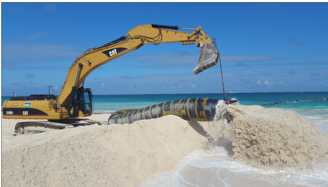
Foto 73. Vertido de la arena en la playa.
