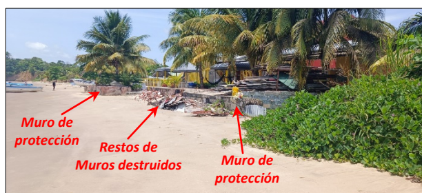
Foto 37. Muros de protección e inmuebles sobre la playa y escombros de su destrucción por el oleaje.
