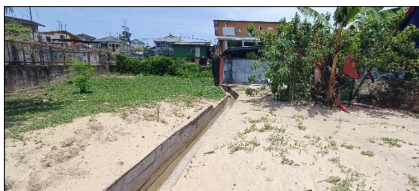
Fotos 31 y 32. Presencia de micro-vertederos de hormigón y cárcava en la playa que canaliza las aguas residuales y del escurrimiento hacia el mar. Parte central Sector 1.
