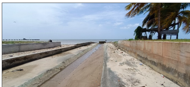
Fotos 33 y 34. Presencia de estructura de hormigón que canaliza las aguas residuales y del escurrimiento hacia el mar. Extremo Oeste Sector 1.
