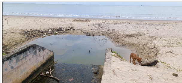
Fotos 29 y 30. Presencia de estructura de hormigón que canaliza las aguas residuales y del escurrimiento hacia el mar. Extremo Este Sector 1.
