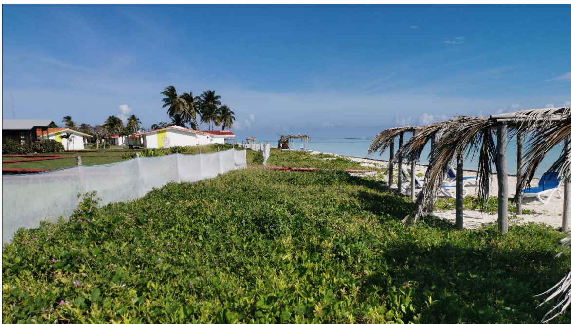
Foto 70. Barreras de contención y captación de arena implementados en playa El Paso, Cayo Guillermo, Cuba.
