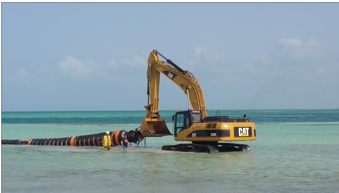
Foto 72. Retroexcavadora colocando el extremo de la tubería en el punto de vertido.
