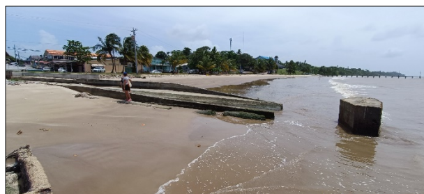
Fotos 33 y 34. Presencia de estructura de hormigón que canaliza las aguas residuales y del escurrimiento hacia el mar. Extremo Oeste Sector 1.
