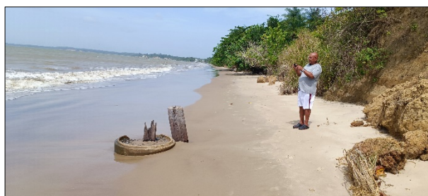
Foto 48. Afloramiento de viejas estructuras por pérdida de arena.
