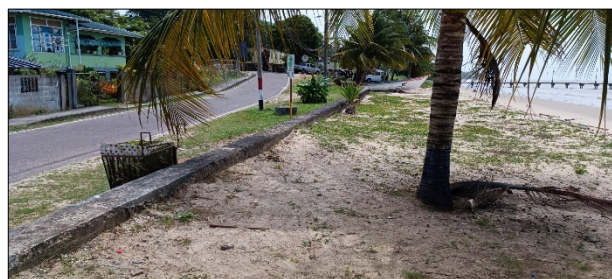
Foto 39. Muro de protección y contención que limita la playa y el vial.
