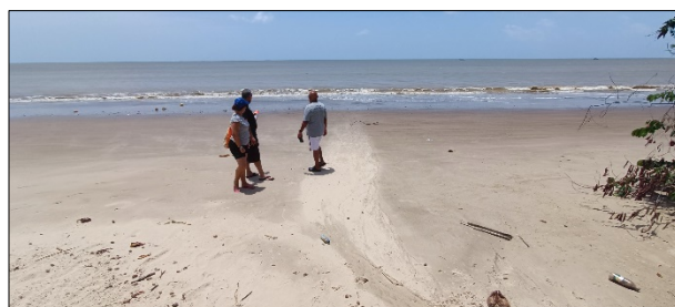
Fotos 31 y 32. Presencia de micro-vertederos de hormigón y cárcava en la playa que canaliza las aguas residuales y del escurrimiento hacia el mar. Parte central Sector 1.
