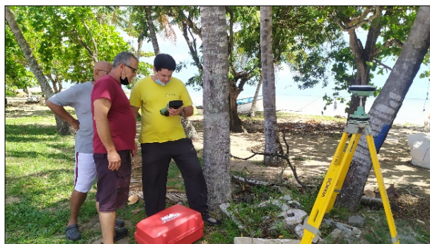
Fotos 3 y 4. Establecimiento de puntos topográficos que sirven como cabezas de los perfiles de playa para la caracterización de la morfología del perfil.
