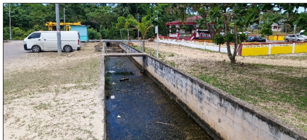
Fotos 29 y 30. Presencia de estructura de hormigón que canaliza las aguas residuales y del escurrimiento hacia el mar. Extremo Este Sector 1.
