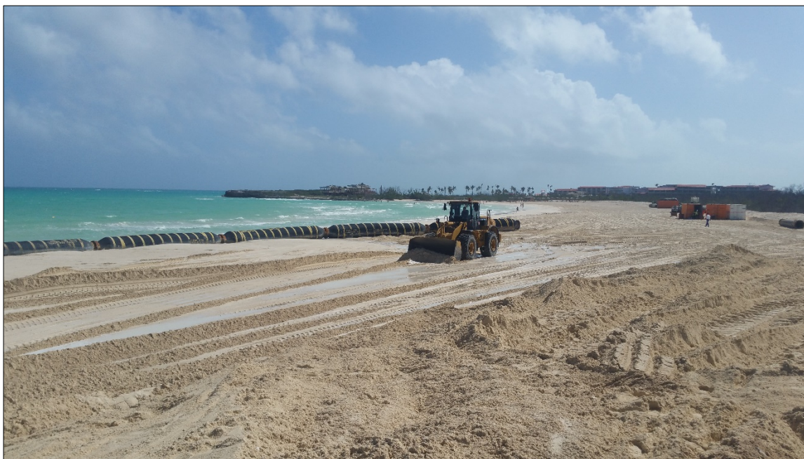
Foto 74. Nivelado y conformación del perfil de playa por medios mecánicos.
