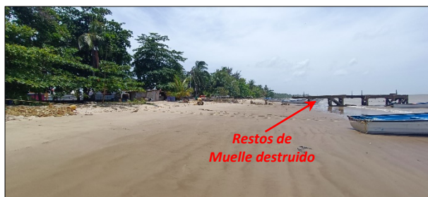
Foto 40. Restos de espigón destruido que aun permanece en la playa.
